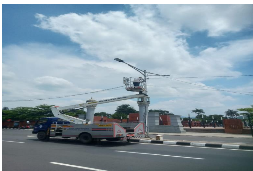
Foto Kegiatan Pembangunan PJU
