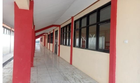
Rehabilitasi ruang kelas SMP 2 Dawuan
